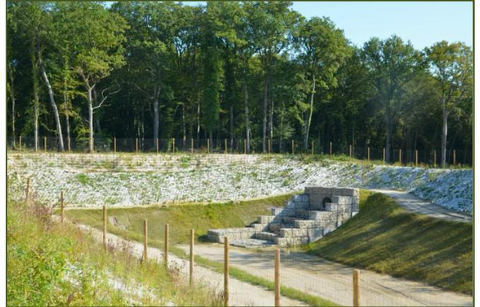
La SNCF a commencé des travaux de sécurisation de la voie ferrée de Reims à Epernay sur la commune de Villers Allerand en 2023. Ces travaux, qui se situent sur le tunnel ferroviaire de Rilly la Montagne à Germaine, avaient pour but d'étancher le tunnel qui présentait de nombreuses zones d'infiltration qui fragilisaient la voûte. Le bassin de rétention a été construit pour absorber les crues soudaines de la Germaine qui inondaient la voie ferrée et perturbaient le trafic ferroviaire.
